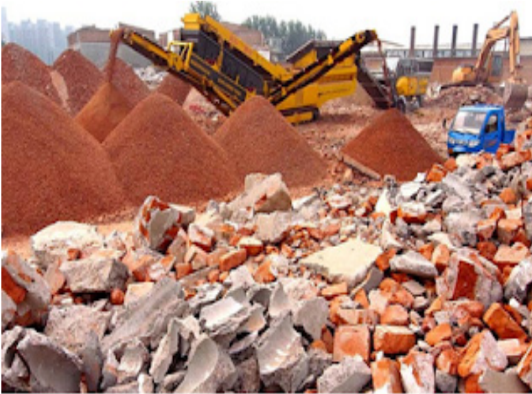
Gambar 6. Proses Recycle Limbah Bongkahan Bata dan Beton
